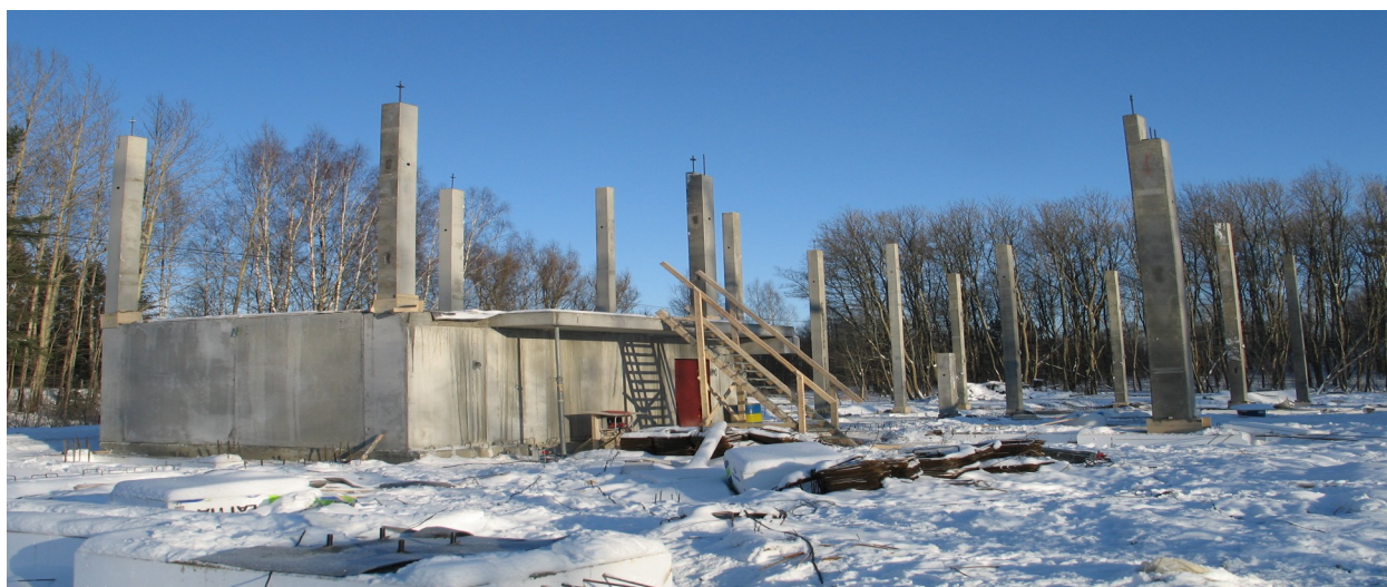
Väestösuoja ja pilarit 31.1.2009
