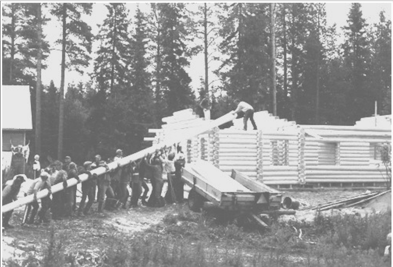
Kuvassa talkooväki nostaa Antti Laurin lahjoittamaa harjaortta Kalevi Leppäkarin veistämän hirsikehikon päälle. Ketterä on Antti Laurilta vuokratulla tontilla. Kuva: Jorma Tikkanen.
