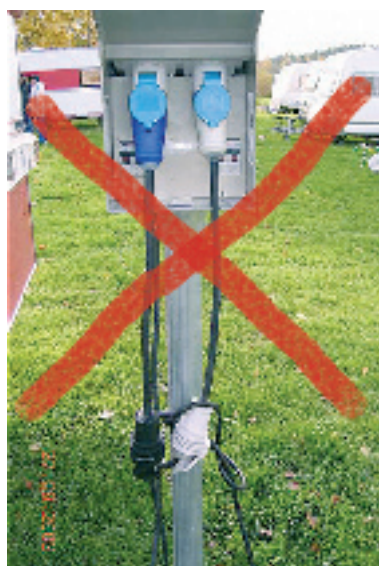
Sukojohdon liittäminen adapterilla ei ole sallittua.
