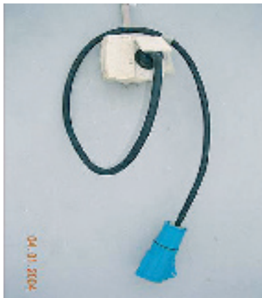
Adapteri, jolla liitäntäjohdon saa liittää sukopistorasiaan.
